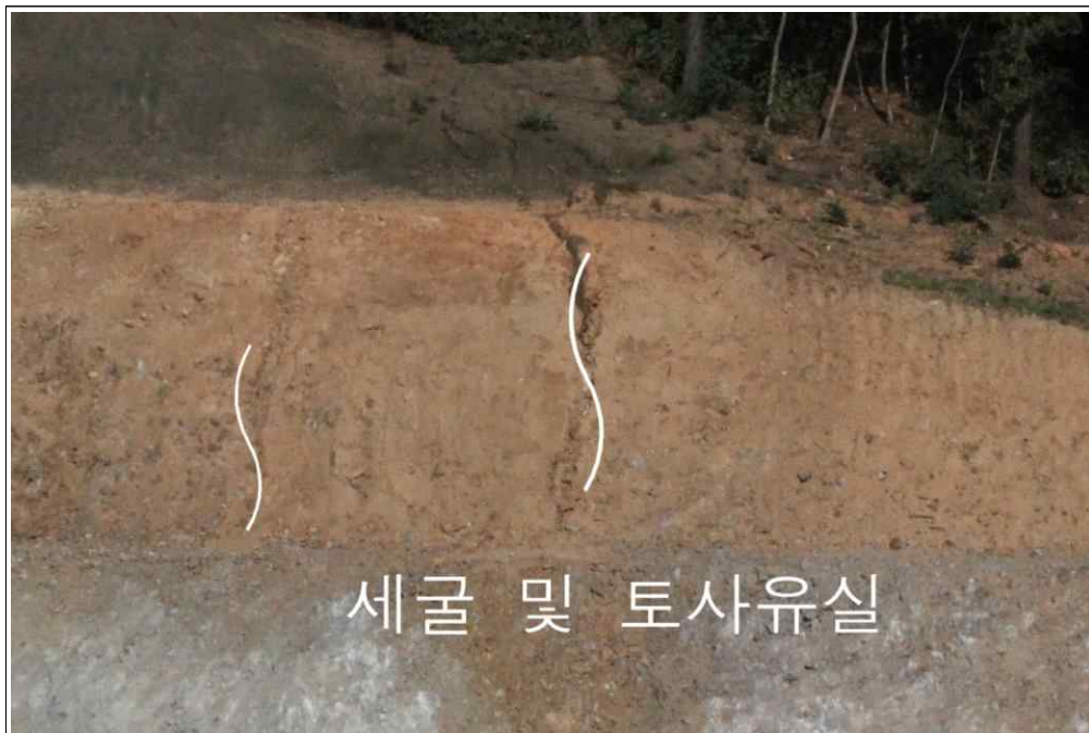
【그림 14】 B 영역에서 관찰된 세굴 및 토사유실
