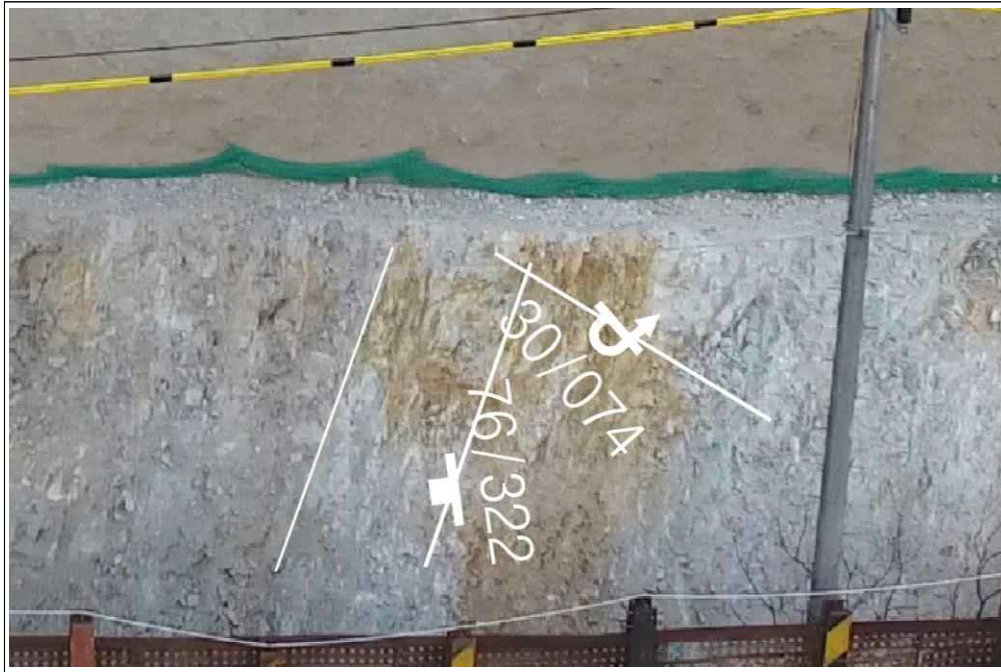
【그림 10】 A 영역에 발달한 불연속면
