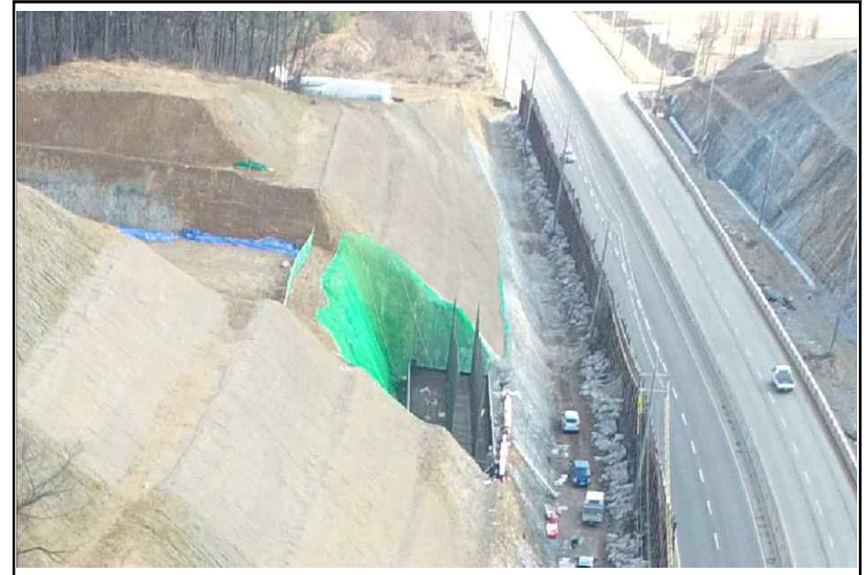
【그림 4】 깎기비탈면 종점부 측면 사진
