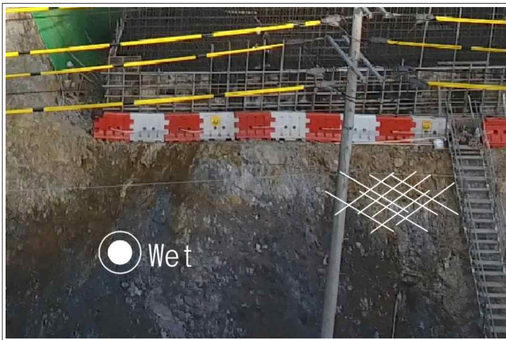
【그림 11】 A 영역에서 관찰된 지하수 누수 및 세편화된 암편(1)
